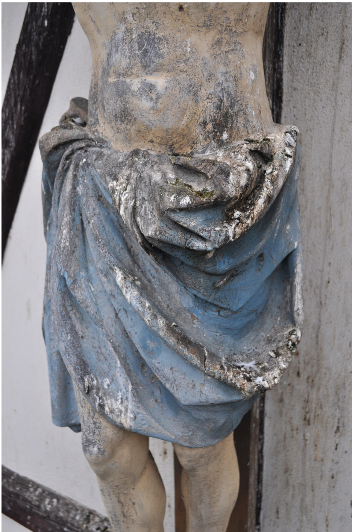
Kristus, Pískov: stav před restaurováním (detail poškození a znečištění).
